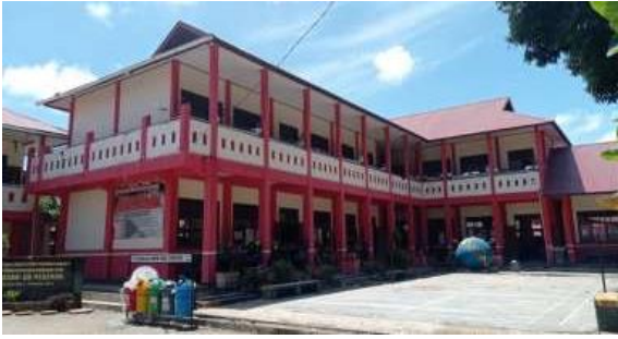
Gambar 2. Gedung B SDN 09 Pasaman
