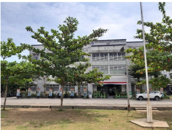
Gambar 2 Gedung SMA Pembangunan Laboratorium
