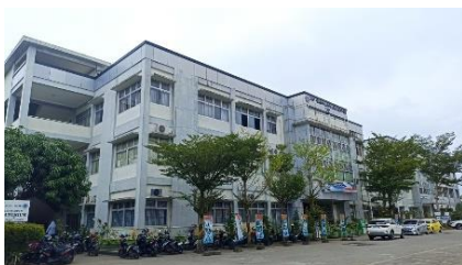
Gambar 1. Gedung SMP Pembangunan Laboratorium UNP
