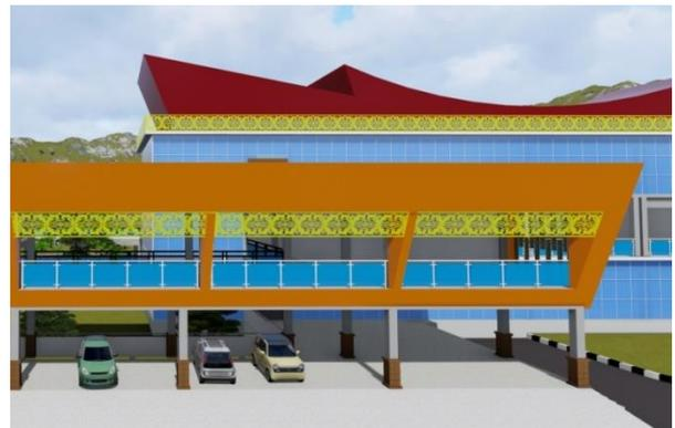
**Gambar 12. Penempatan ACP Relief pada Gedung**
