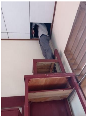
Gambar 13. Pengujian Hammer Test Pada Ring Balok Lantai 2
