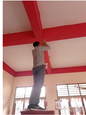
Gambar 11. Pengujian Hammer Test Pada Balok Lantai 1 Tipe 2
