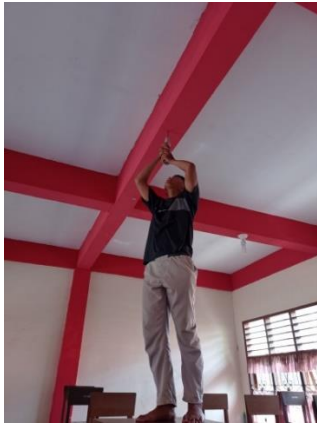
Gambar 9. Pengujian Hammer Test Pada Balok Lantai 1 Tipe 1
