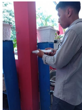
Gambar 7. Pengujian Hammer Test Pada Kolom Lantai 2
