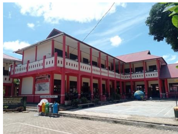
Gambar 1. Gedung B SDN 09 Pasaman
