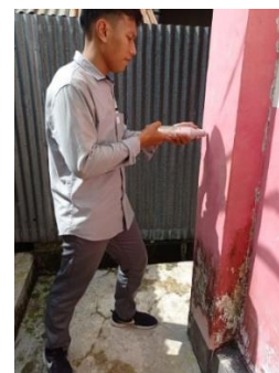
Gambar 5. Pengujian Hammer Test Pada Kolom Lantai 1
