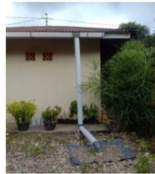
Gambar 2. Konstruksi Alat Infiltrasi Buatan
