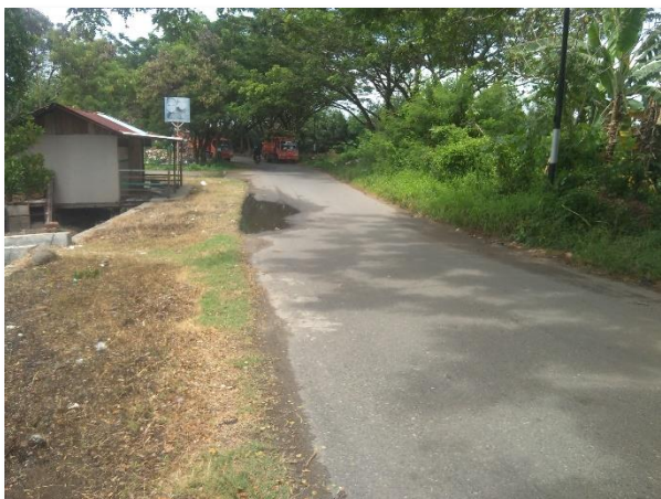
Gambar 1. Kondisi Jalan Patenggangan Sumber: Survei lapangan
