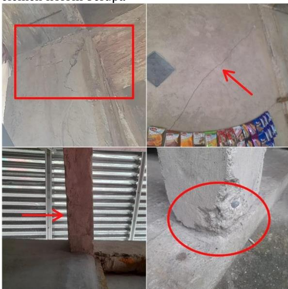
Gambar 3. Kerusakan Elemen Kolom, Balok, dan Dinding
