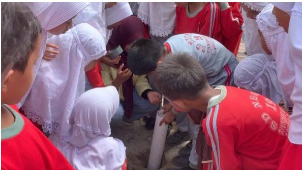
Gambar 6. Pemasangan Pipa Biopori oleh Siswa
